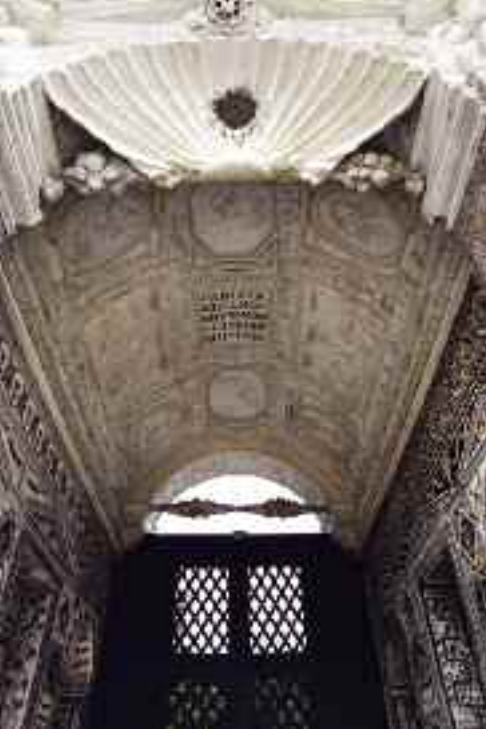
Fig. 95. Propileo nord sul cortile ovale, interno.
